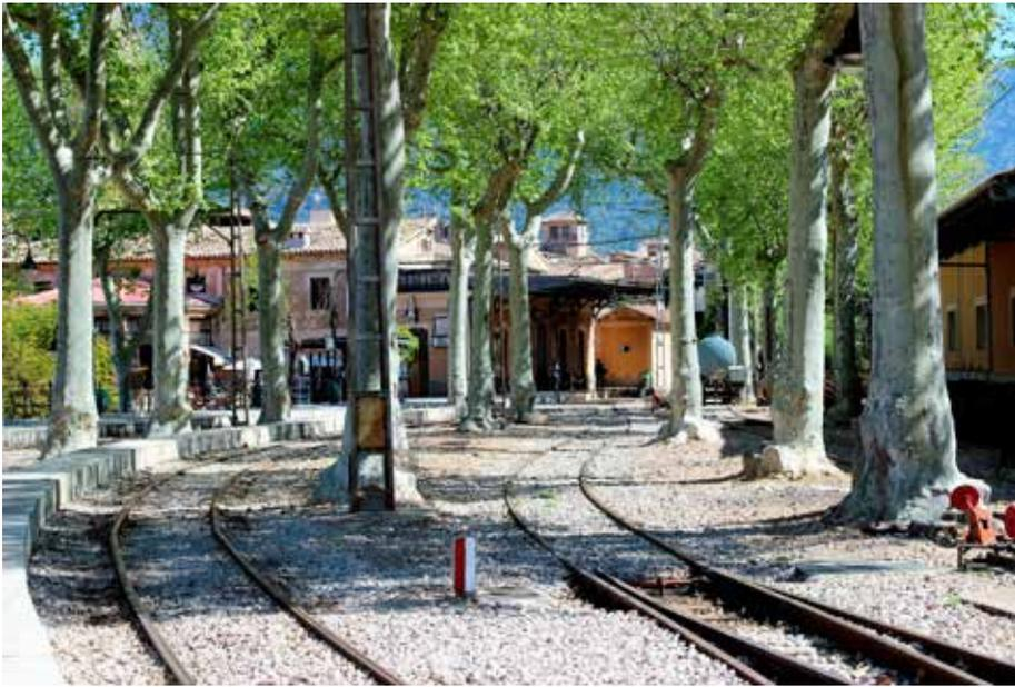
Der Bahnhof von Sóller mit seiner einzigartigen „Platanen-Halle“ (2014). Die ursprüngliche Spurweite von 914 mm blieb hier im Gegensatz zu den übrigen, auf 1000 mm umgespurten Linien Mallorcas erhalten.
