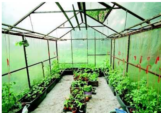
Tilava huone, joka on katettu uv-suojatulla kasvihuonekalvolla.
