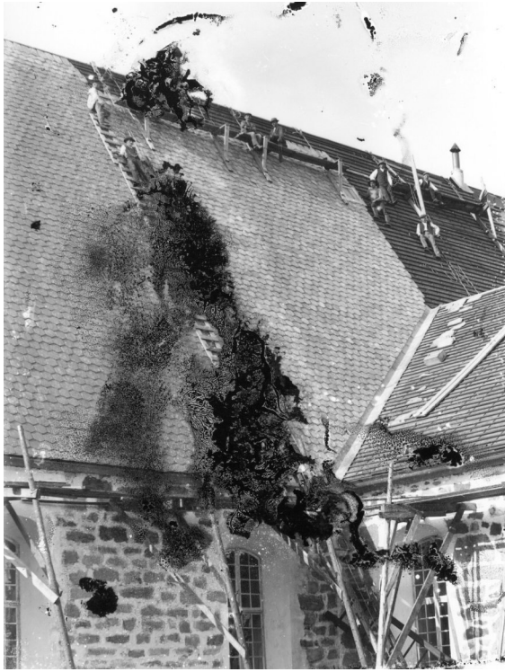
Lasinegatiivi kesän 1913 kattoremontista on aika pahoin tuhoutunut. Kuvasta erottaa kuitenkin kahdeksan miestä erittäin jyrkällä katolla ilman mitään turvavarusteita. Lavakin on vain kahden lankun levyinen ja tikkaat kevytrakenteiset. Kuva: Kotiseutuarkisto.
