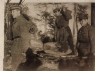
Подноска камней для строительства огневой точки.
