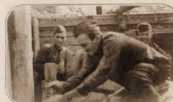
На оборудовании подземной кухни.
