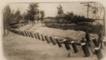
Строительство противотанковых деревьев надолб.
