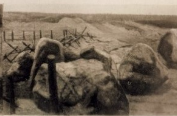
Противотанковые каменные надолбы.
