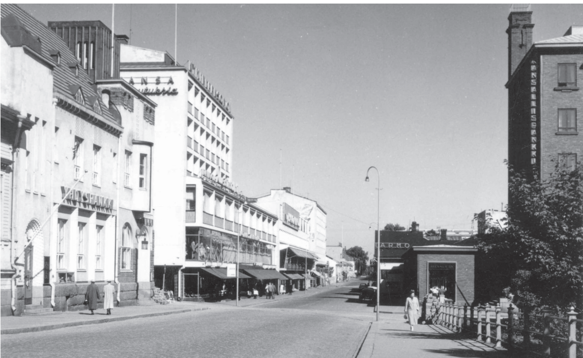
Kirkkokatu ja Keskuskatu rajasivat kaupungin keskustan 1950-luvullakin. Kirkkokadun vanhoja puutaloja alkoi hävitä uusien rakennusten tieltä. Vuonna 1955 Kirkkokadun ja Ruotsinsalmenkadun kulmassa ollut vanha Kymnlaakson Osuusliikkeen puurakennus vaihtui uuteen kuusikerroksiseen rakennukseen. Viikonloppuna oli Kirkkokadulla näinkin rauhallista puolen päivän aikaan kesäkuussa 1957. Kuva Albin Aaltonen.
