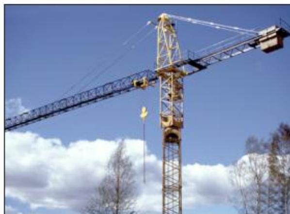
Betox 100 nosturin yläosa kuvattuna vuonna 1991. Kuvassa näkyvät muutokset ohjaamon paikassa, kulkuteissa ja kääntölaakerin liitoskohdan vahvistukset. / Top section of the Betox 100 crane. Photo taken in 1991. The image shows changes in the place of the operator's cabin, access routes, and the reinforcement plates at the slewing bearing connection point.
