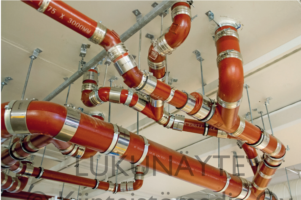
Kattoon asennettuja viemäriputkia. Kuva: Klaus Pulli
