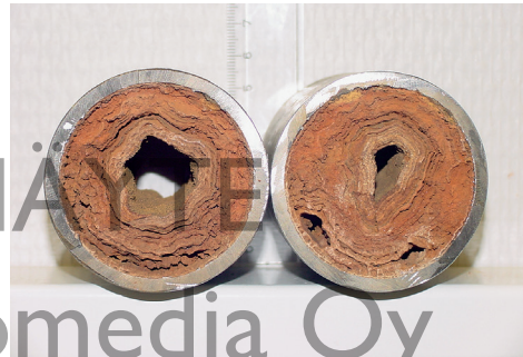
Ruosteen täyttämät sinkityt teräsputket. Kuva: Bauer Wassertechnology Oy
