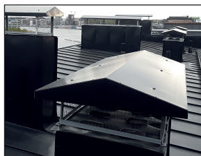
Kuva 67. Erilaisia ilmanvaihtokanavia. Vasemmalla paikalla rakennettu, kellarissa sijaitseva painovoimaisen ilmanvaihdon vaakakanava. Keskellä nykyaikainen tehtaalla valmistettu kierresuomakanava, jossa tehdasosat on liitetty niiteillä toisiinsa. Oikealla 1930-luvun asuin- ja toimistorakennuksen kattokuvaa, jossa rakenneaineiset painovoimaiset hormit (tiilihormit) ovat katoksella varustetun peltisuojausten takana. Kuvat: Tapio Korkala.
