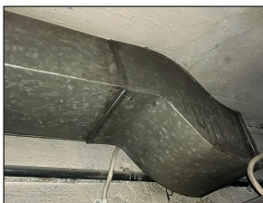
Kuva 67. Erilaisia ilmanvaihtokanavia. Vasemmalla paikalla rakennettu, kellarissa sijaitseva painovoimaisen ilmanvaihdon vaakakanava. Keskellä nykyaikainen tehtaalla valmistettu kierresuomakanava, jossa tehdasosat on liitetty niiteillä toisiinsa. Oikealla 1930-luvun asuin- ja toimistorakennuksen kattokuvaa, jossa rakenneaineiset painovoimaiset hormit (tiilihormit) ovat katoksella varustetun peltisuojausten takana. Kuvat: Tapio Korkala.
