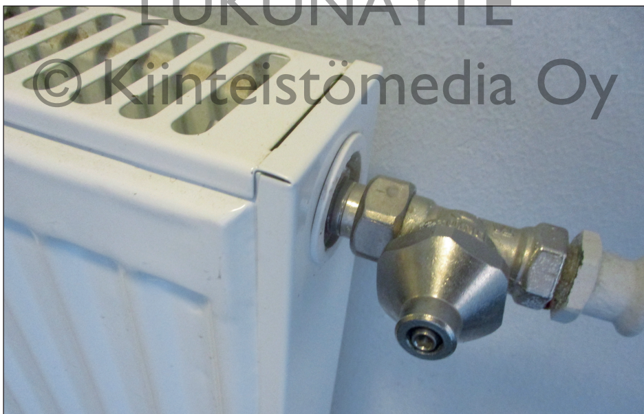
Kuva 41. Nykyaikainen vandaalisuojattu, käsisäädettävä patteriventtiili yhteisiin tiloihin. Kuva: Tapio Korkala.
