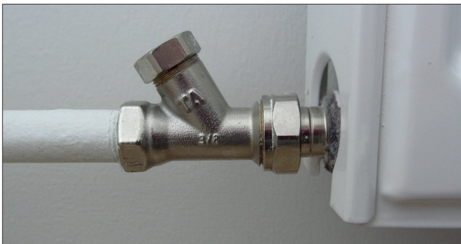
Kuva 45. Patterin paluuventtiili, jossa on mukana sulkuventtiili. Kuva: Kiinteistömedia Oy.
